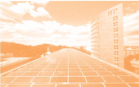
más comúnmente usado en la fabricación de los módulos fotovoltaicos es el silicio; la eficiencia típica de estos módulos en condiciones estándar de irradiancia y temperatura (i.e., 1,000W/m<sup>2</sup>, 25°C, AM1.5) se encuentra entre 12 y 15% para silicio monocristalino, entre 11 y 14 %, para silicio policristalino; y entre 5 y 7 % para los de silicio amorfo.
